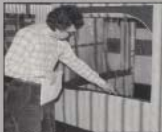
Deckleisten schützen die Nähte vor Regen und Wind
